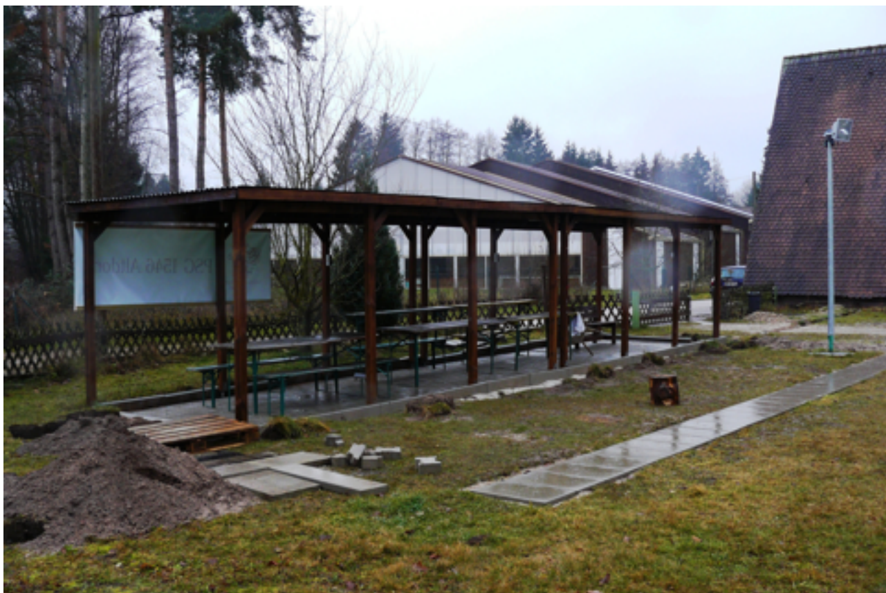
(Anlage: Bild vom Bogen-Unterstand, Rohbau)
